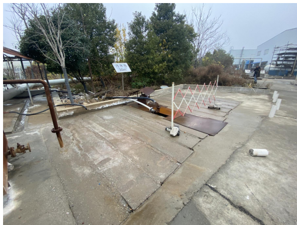
废水收集沉淀池和排放口
